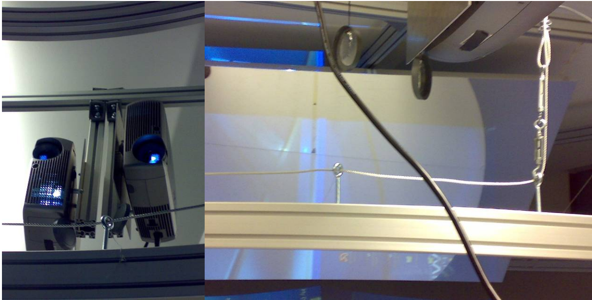
Bild 7) Befestigung der Deckenprojektoren und -spiegel
