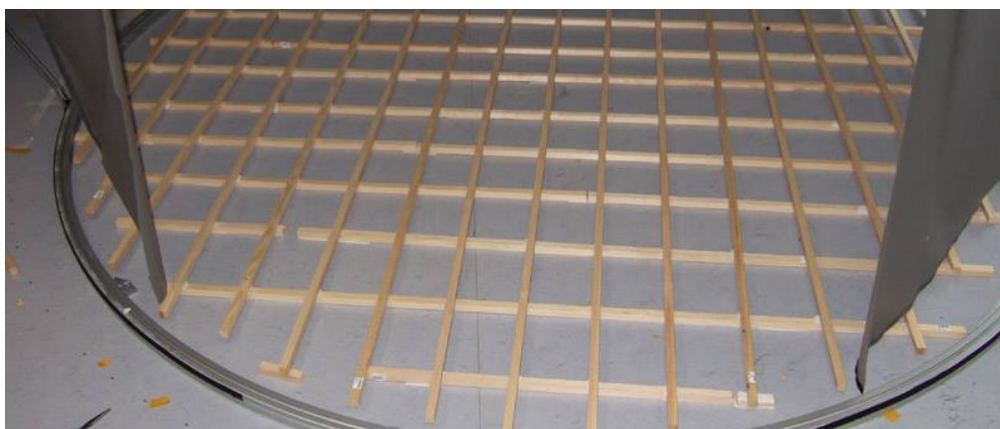
Bild 5) Gitterstruktur aus Kanthölzern unter den Bodenplatten
