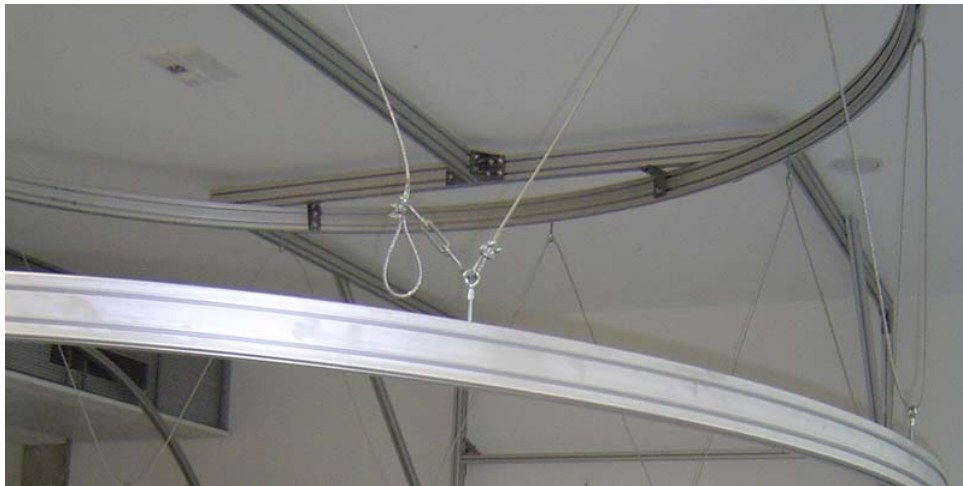
Bild 4) Aufhängung des oberen Zylinderrings am Trägerring
